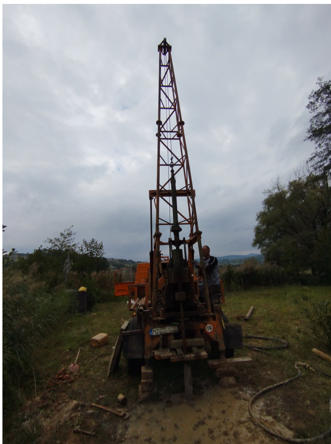
Slika 4. Izvođenje istražne bušotine
